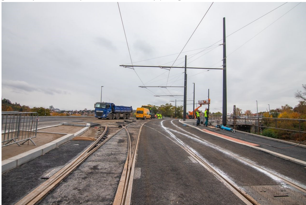
Obr. 2 - rekonstrukce tramvajové tratě v Nádražní ulici s kolejovým rozvětvením na (tehdy připravovaný) Dvorecký most, 2020 (prazsky.denik.cz)
